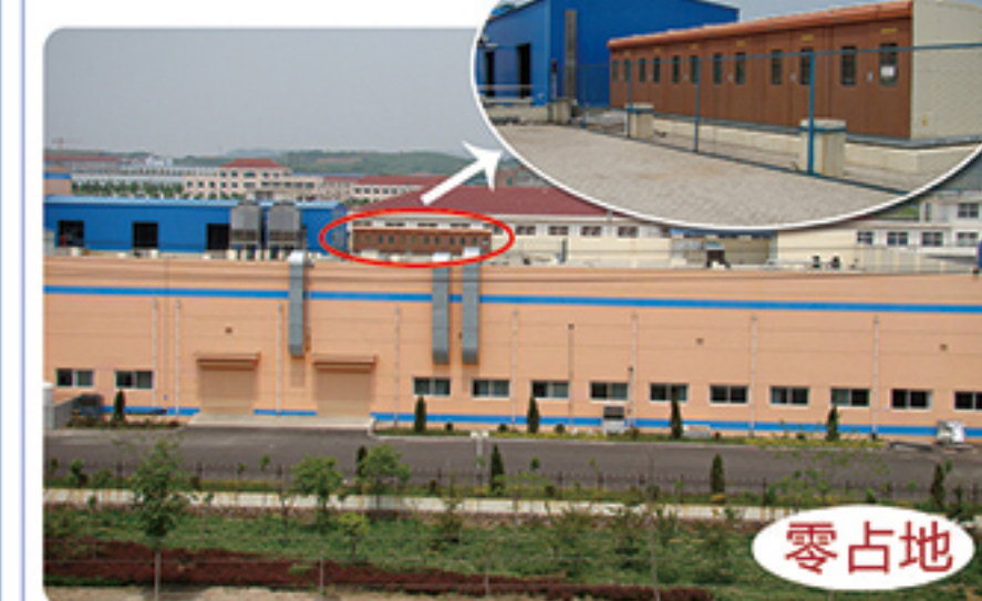
工矿企业屋顶型1600KVA*3
