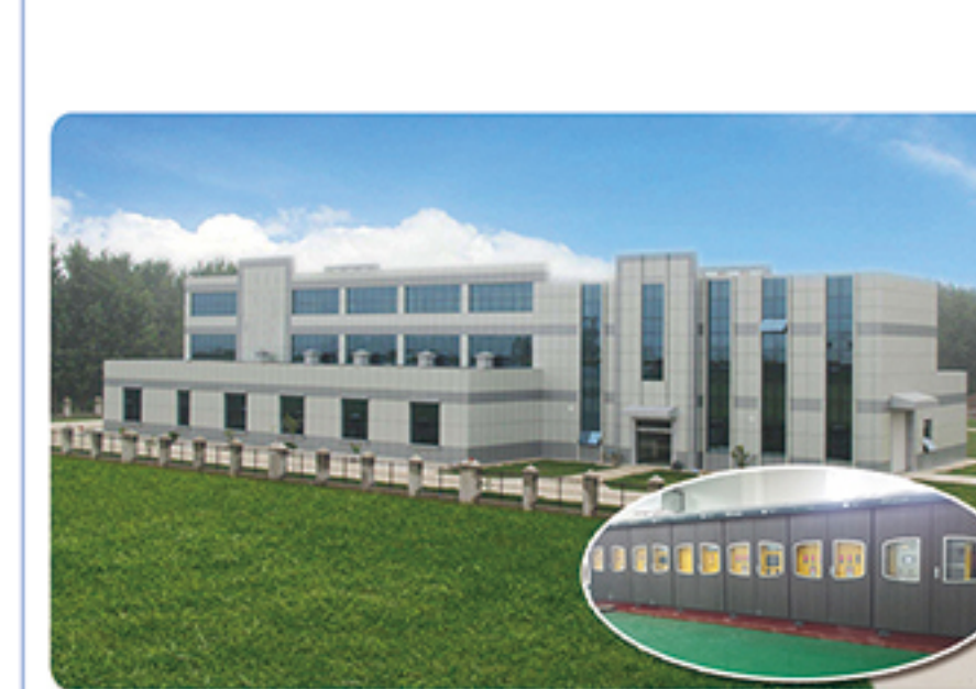
城市排水泵站2000KVA*2
