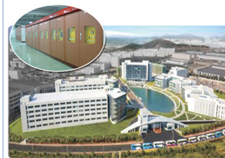
上市公司产业园800KVA*4+1000KVA*4
