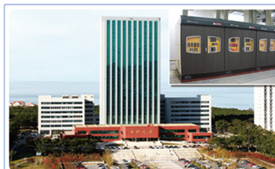
政府机关 800KVA*3
